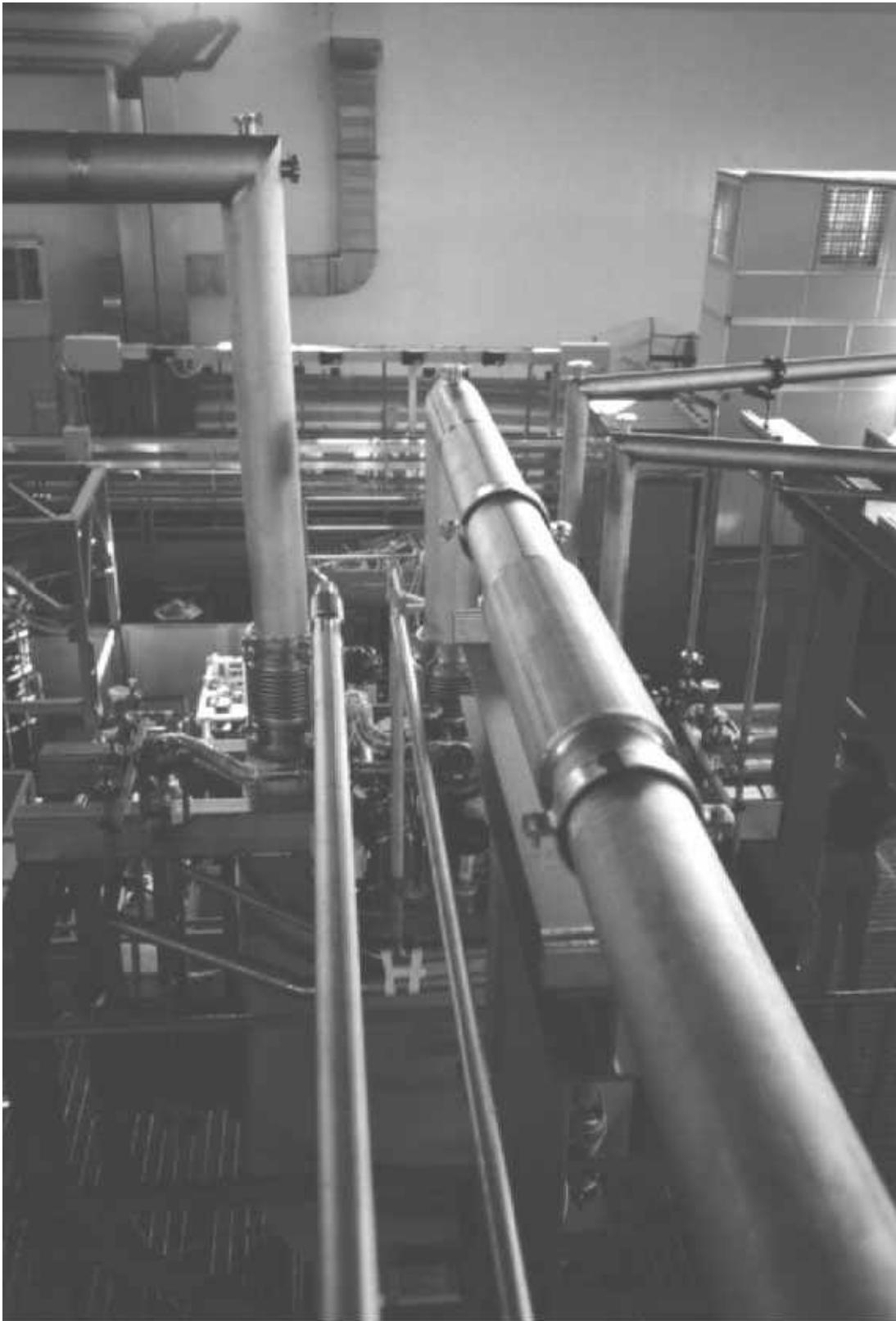
Figura 3 : Vista della flangia superiore della Valve Box criogenica con le connessioni delle Linee di Trasferimento Criogeniche: a KLOE (a sin), alla Cold Box (al centro) e ai magneti Compensatori di FINUDA (a des.)
