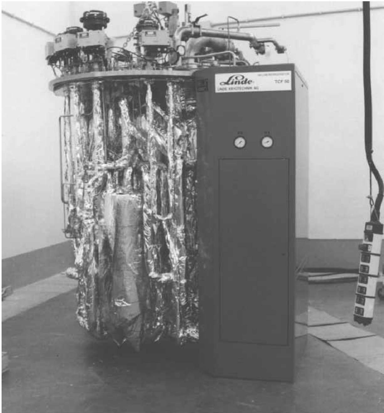
Figure 2 : La Cold Box dell'Impianto LINDE (aperta) durante l'installazione
